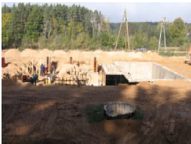
Ūdens atdzelžošanas stacijas izbūve
