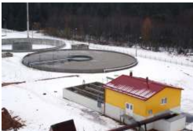
Notekūdeņu attīrīšanas iekārtu izbūve
