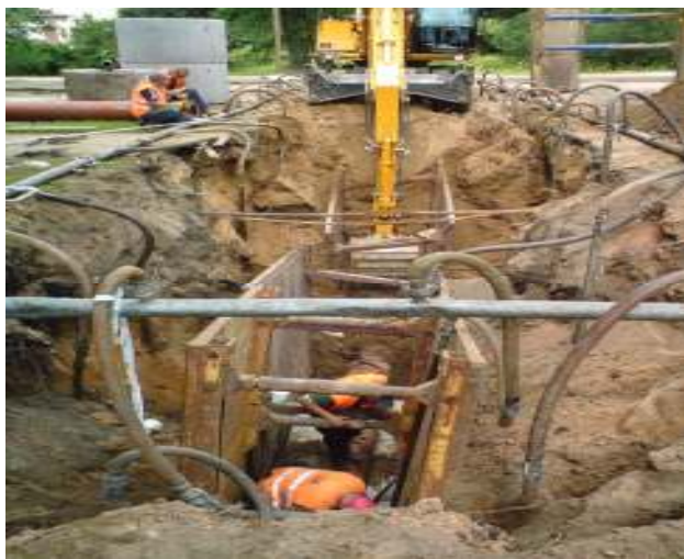
Tīklu būvniecības process
